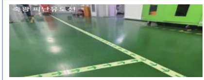
피난 유도선 설치
